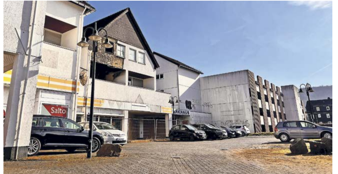
Der Abriss des ehemaligen Eins-A-Komplexes startet Anfang März. Ab dann stehen die temporären Parkplätze im Bereich des Areals zunächst weitgehend nicht mehr zur Verfügung. (Foto: Stadt Bad Berleburg)
